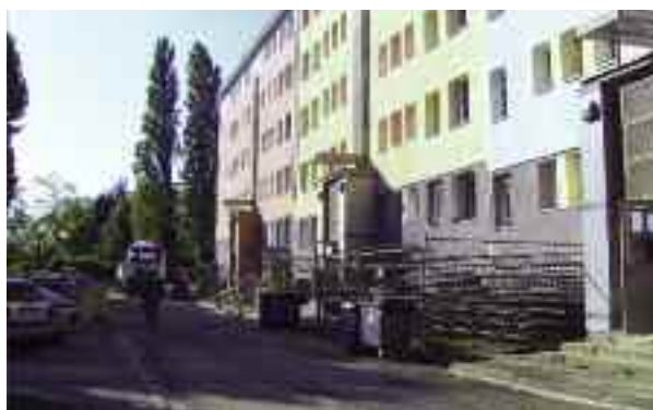
Batiment J de l'Opievoy, en cours de résidentialisation, rue La-Bruyère.
