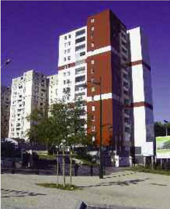
Tour 35 de Logement Francilien, après travaux de réhabilitation, rue Léon-Blum
